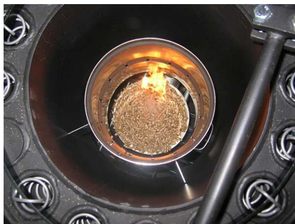
Foyer d'une chaudière à granulés de bois : source Okofen
